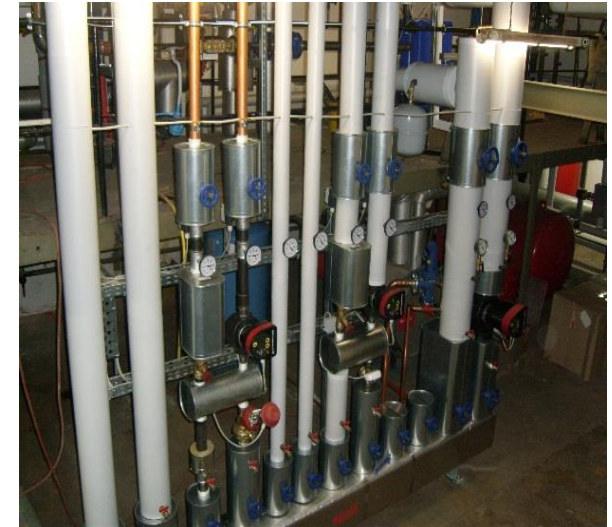
Neue Heizungsverteilung Fernwärme
