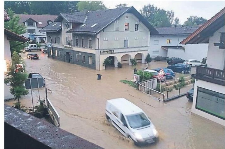
Monsuntiger Regen verwandelte das Ortszentrum von Glonn in ein Schlammbad.
