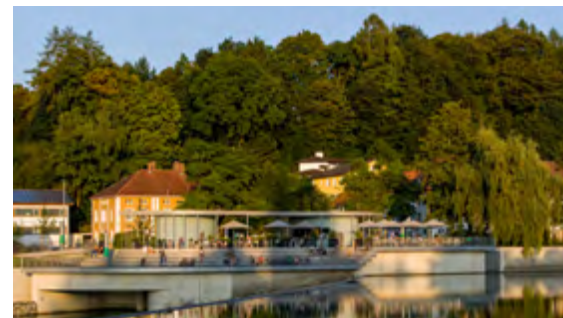
Neues Wasserkraftwerk „Kaufbeurer Straße“
